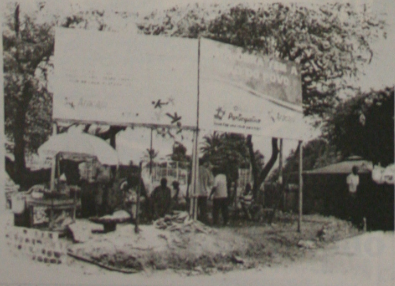
A obra inacabada, na praça do Siqueira Campos revolta comerciantes
