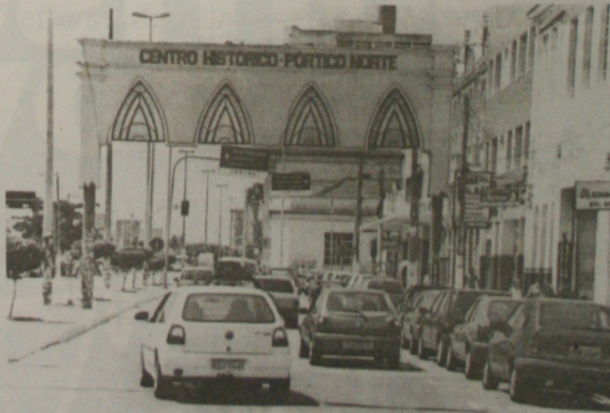
Os pórticos construídos pela prefeitura necessitam de reparos para manter a originalidade
