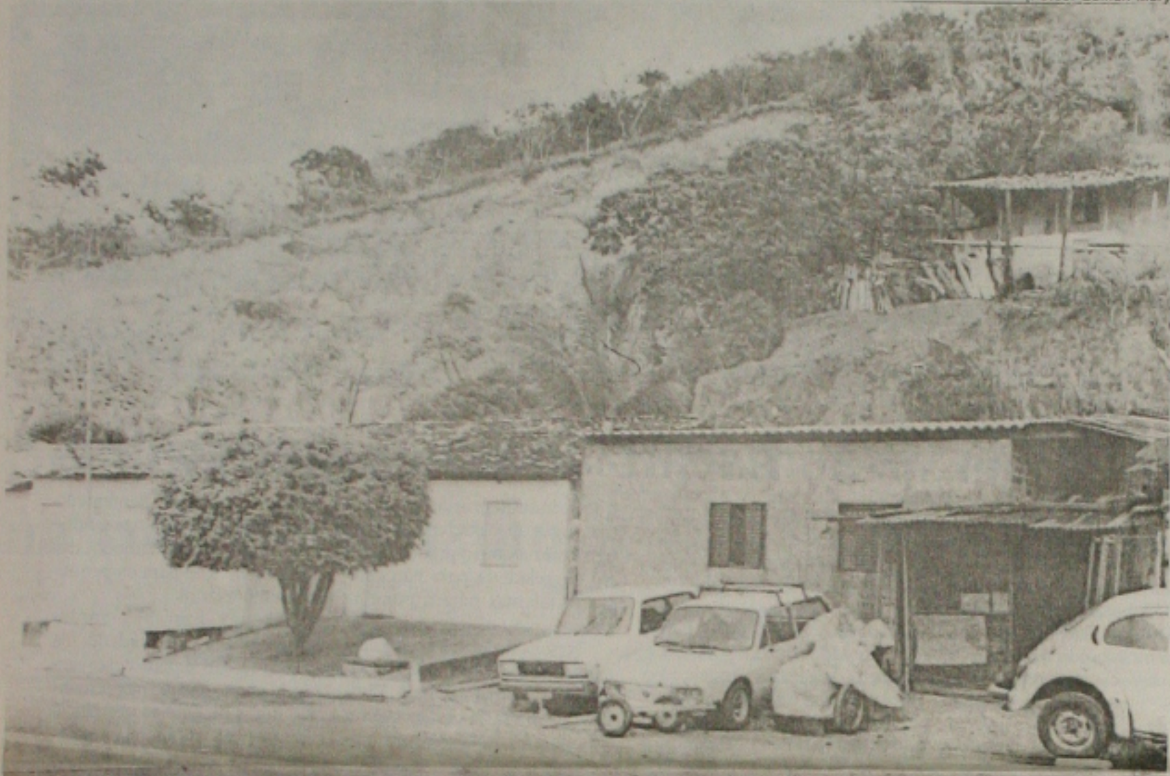
Moradores do Morro do Urubu reivindicam a construção de um muro de arrimo para proteção das encostas
