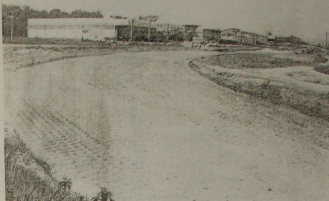
A conclusão da obra de duplicação da BR-101 será solicitada pelo governador João Alves em Brasília
