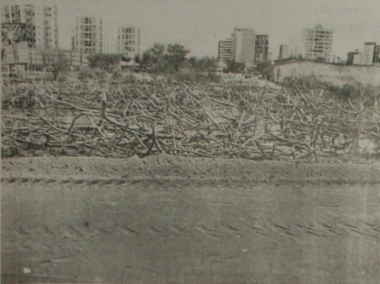
O terreno começou a ser aterrado desde o início da semana a 30 metros do Parque Tramandai nos Jardins
