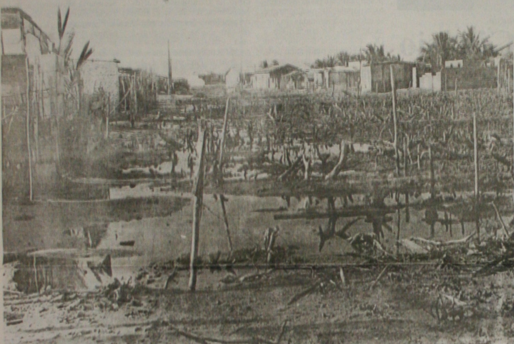
As obras de contenção vão evitar que ocorram novas invasões nos mangues da Coroa do Meio
