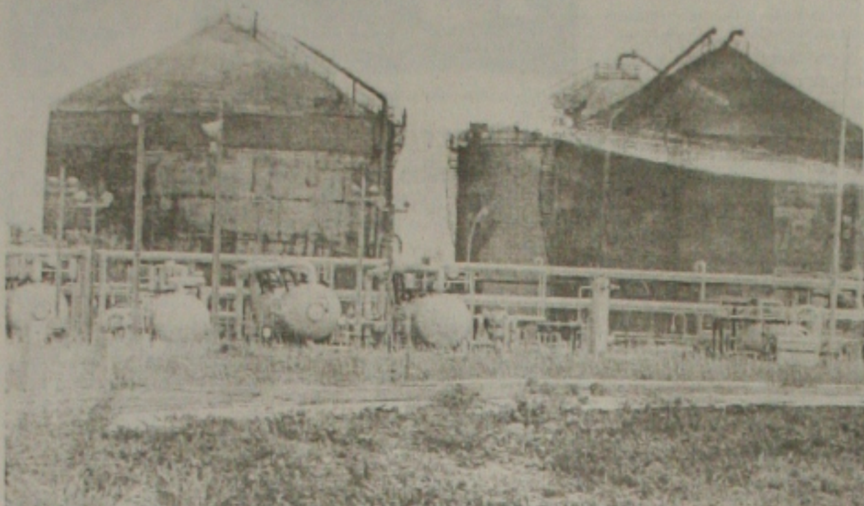
Três dos cinco tanques do Tecarmo da Petrobras foram destruídos pelo fogo
