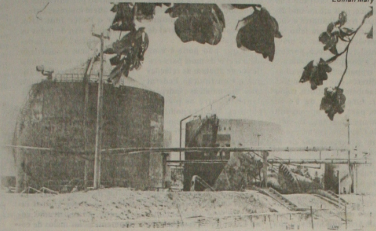
Um dos reservatórios foi totalmente destruído e a cobertura deslocada a 50 metros de distância com a explosão
