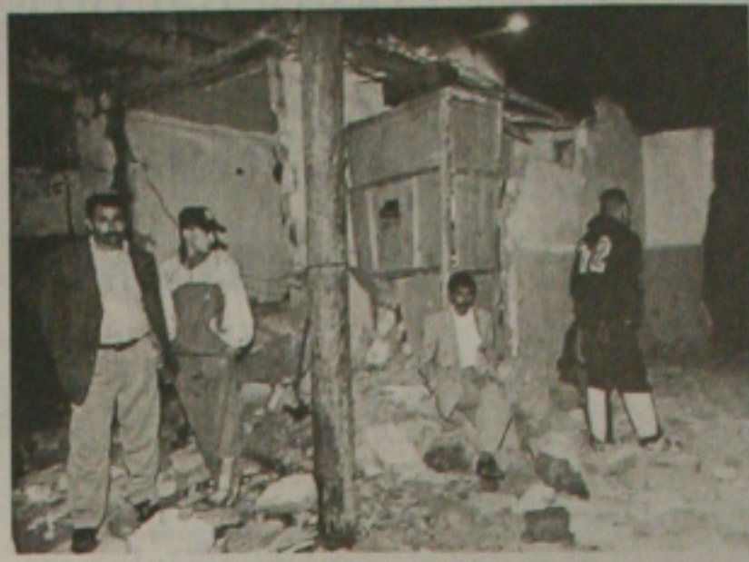
Destrução do Clube Espanhol, atingido pelos terroristas em Casablanca
