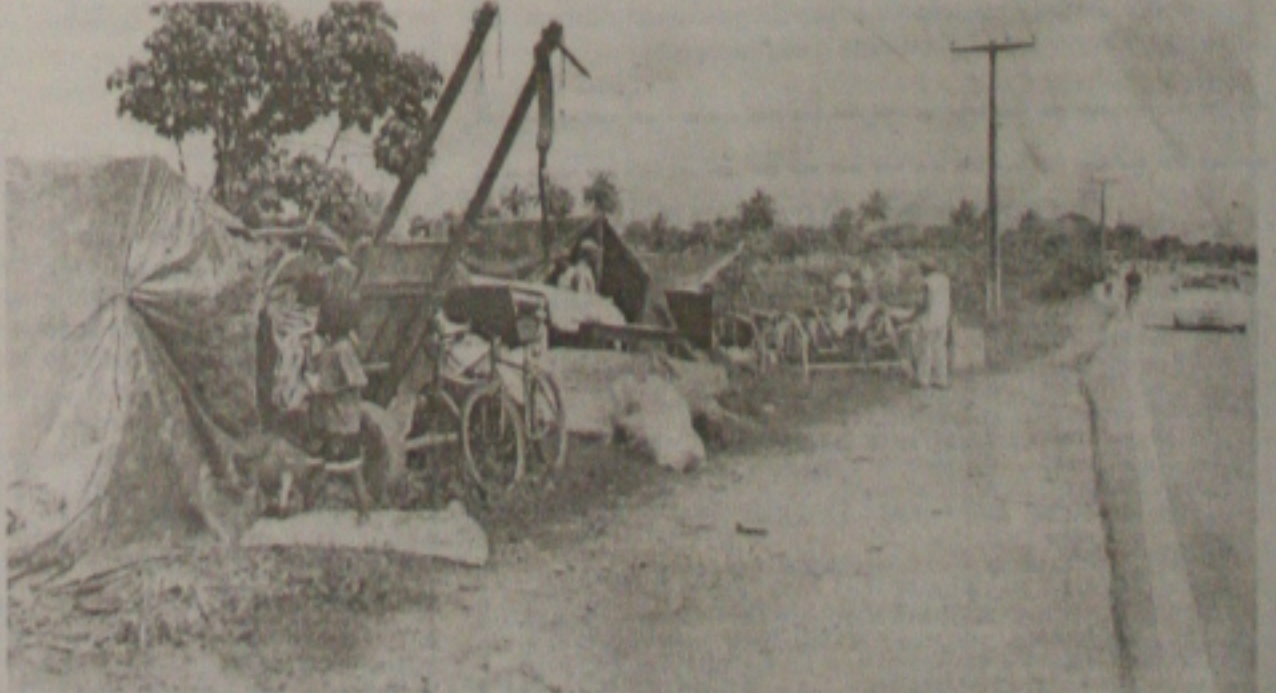
Despejadas na quinta-feira dos barracos, os sem-teto acamparam às margens da avenida, sem saber para onde serão transferidas
