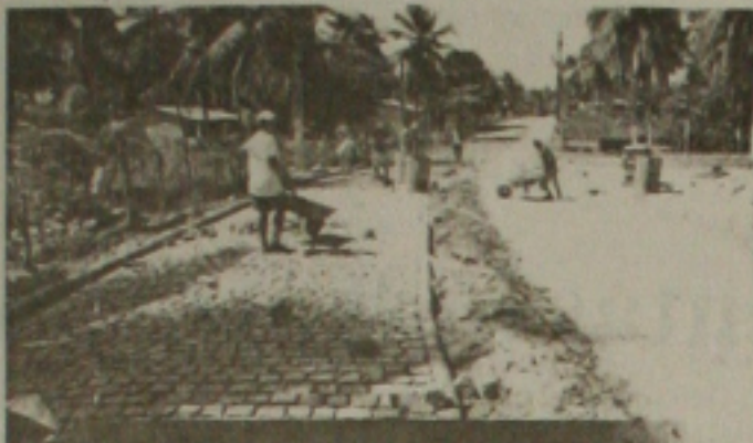
Pavimentação - Lagoa Redonda
