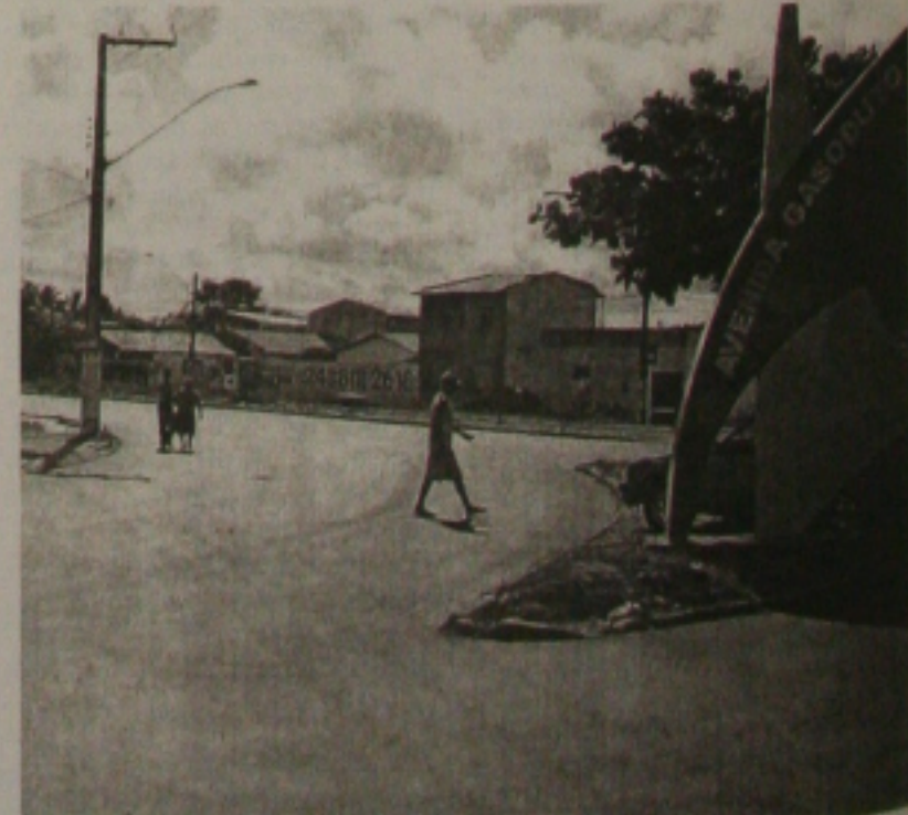
Avenida Gasoduto ganha novo aspecto com realização de obras de infra-estrutura pela PMA
