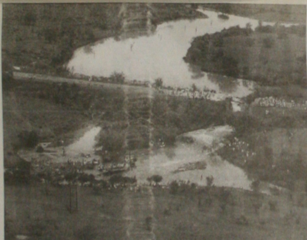
Em Monte Alegre, trecho da rodovia SE-206 desabou, provocando a queda de três veículos e a morte de duas pessoas
