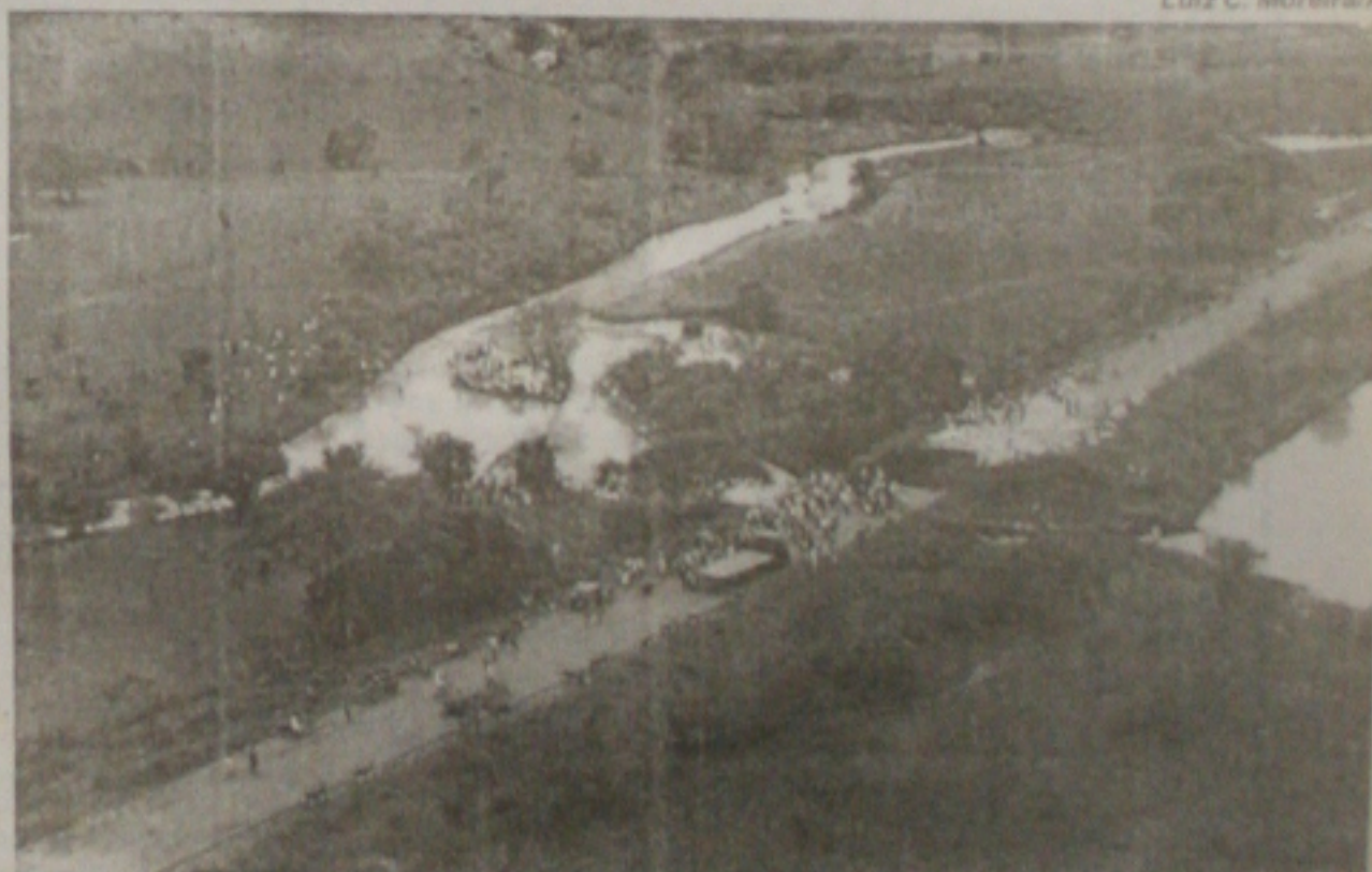
A partir de hoje, o batalhão de engenharia do Exército passa a construir pontes nas áreas que ficaram isoladas depois das chuvas, como em Monte Alegre
