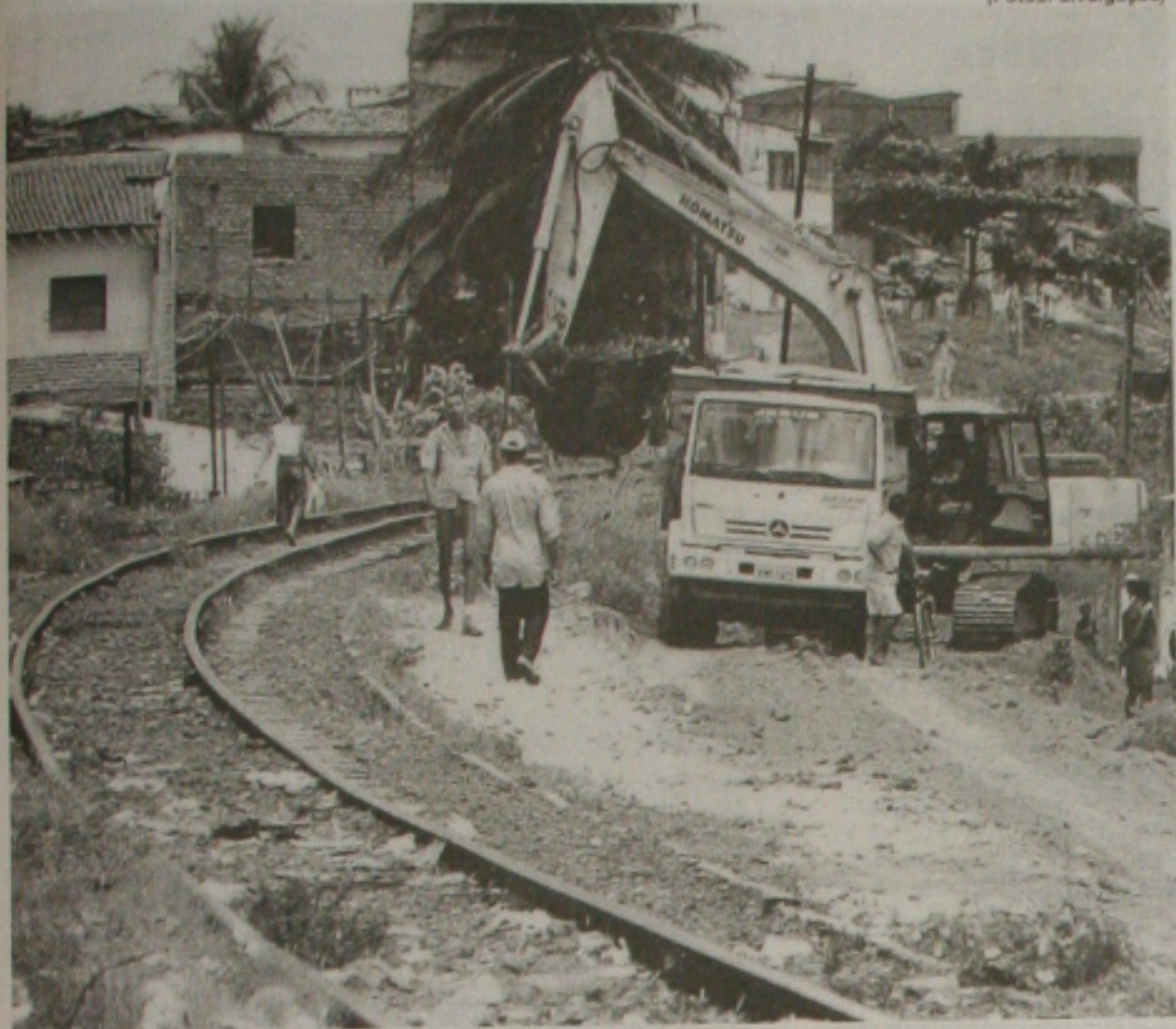
Prefeitura de Aracaju prossegue com as obras da terceira etapa da avenida São Paulo
