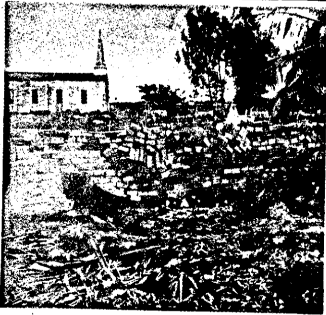
Assim está o muro do Cemitério São João, no Conjunto Castelo Branco: caindo. Os vereadores já estão cansados de pedir ao prefeito uma providência, por menor que seja. Enquanto ela não vem, o resto do muro vai caindo.
