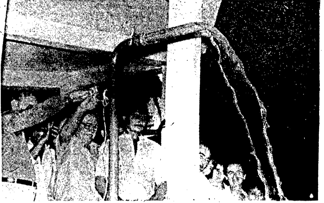
Em Glória a inauguração da Adutora do Alto Sertão
