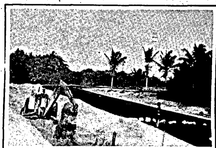
Fase final nas obras de abertura da Av. Murilo Dantas do Farol.
