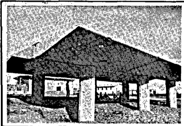
Terminal de Bairro do Conjunto Santa Tereza, em construção.
