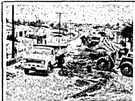
Pavimentação e drenagem da Av. Camilo Calazans, em execução.
