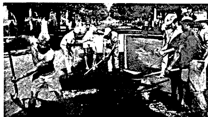
Outra ação da Operação Impacto: obras de asfaltamento na avenida Barão de Maruim.
