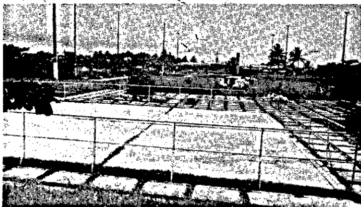
Praça Durval Andrade, uma das grandes obras da atual administração municipal.
