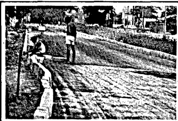
Pavimentação da Av. Pedro Paes de Azevedo, em adiantado estado de construção.
