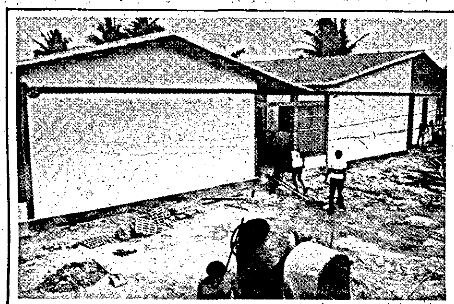
Ação Social João de Oliveira Sobral, em construção no bairro Santos Dumont.
