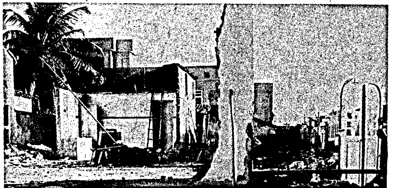
Iniciada a construção do Hotel Jangadeiro, localizado na esquina de Estancia com Santa Luzia. Quando pronto, integrará a rede de hotéis que terá a Capital sergipana para exploração do turismo. A foto fixa o momento em que velhas casas eram derrubadas para dar lugar a um prédio novo e moderno, o Hotel Jangadeiro.
