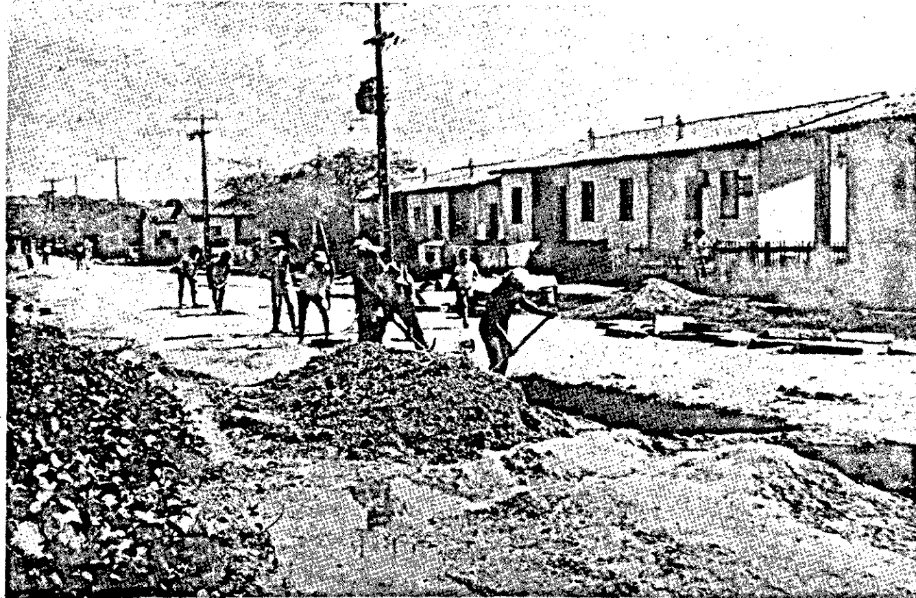
Drenagem na rua Rio Grande do Sul
