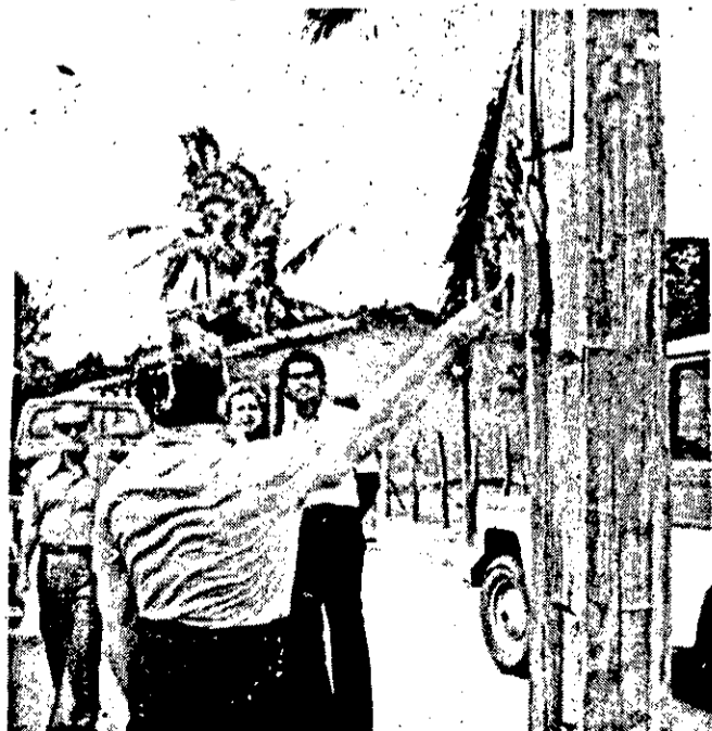
O Governador Paulo Barreto de Menezes, liga a chave, que dá por inaugurado o serviço de luz elétrica ao povoado Riacho Fundo.
