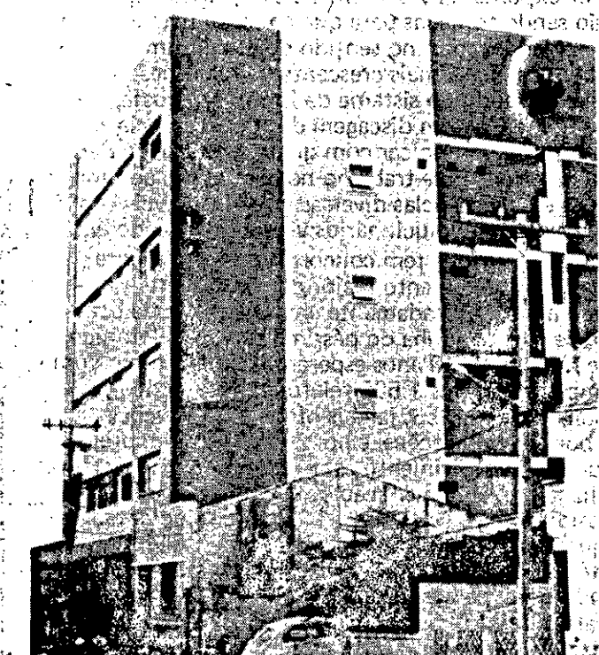
O moderno edifício da Telergipe em nossa capital, erguido obedecendo rígidas normas técnicas. Dez mil terminais telefônicos.
