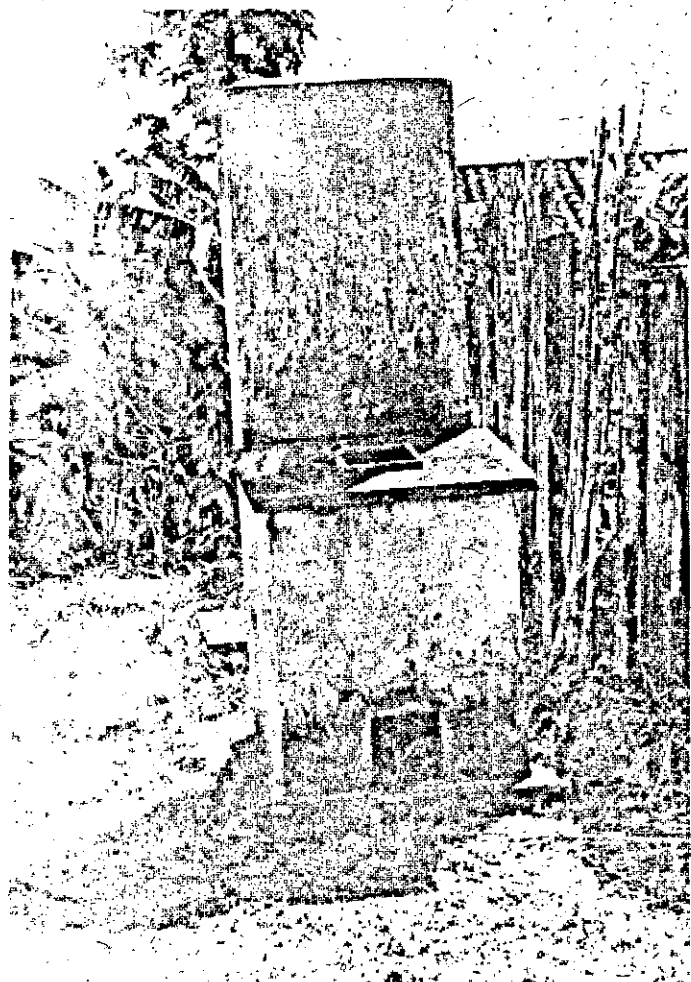
Melhoria sanitária em escola - Incinerador
