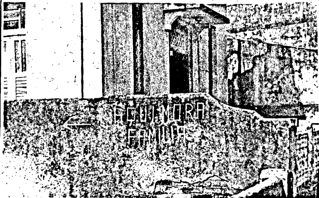
Nos muros também é preciso colocar o aviso, para que não aconteça o que ocorre no cemitério
