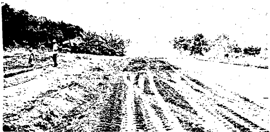
A CONSTRUTORA ARAÚJO, executa serviços de terraplenagem para construção de fábricas, rodovias, conjuntos residenciais e diversas outras finalidades.
