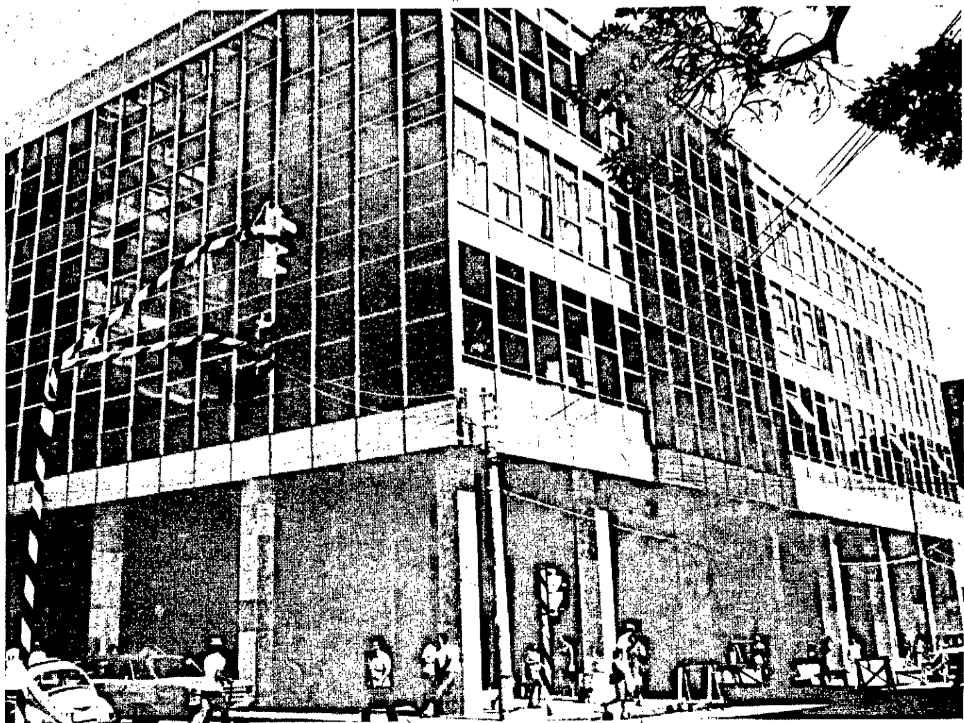
Todas as fundações do sofisticado edifício-sede da Caixa Econômica de Sergipe, foram realizadas pela Cerqueira & Machado. A ação empresarial e a capacidade técnica do engenheiro Gercy Pinheiro Machado, asseguram à sua empresa a participação nas mais importantes obras do Estado.
