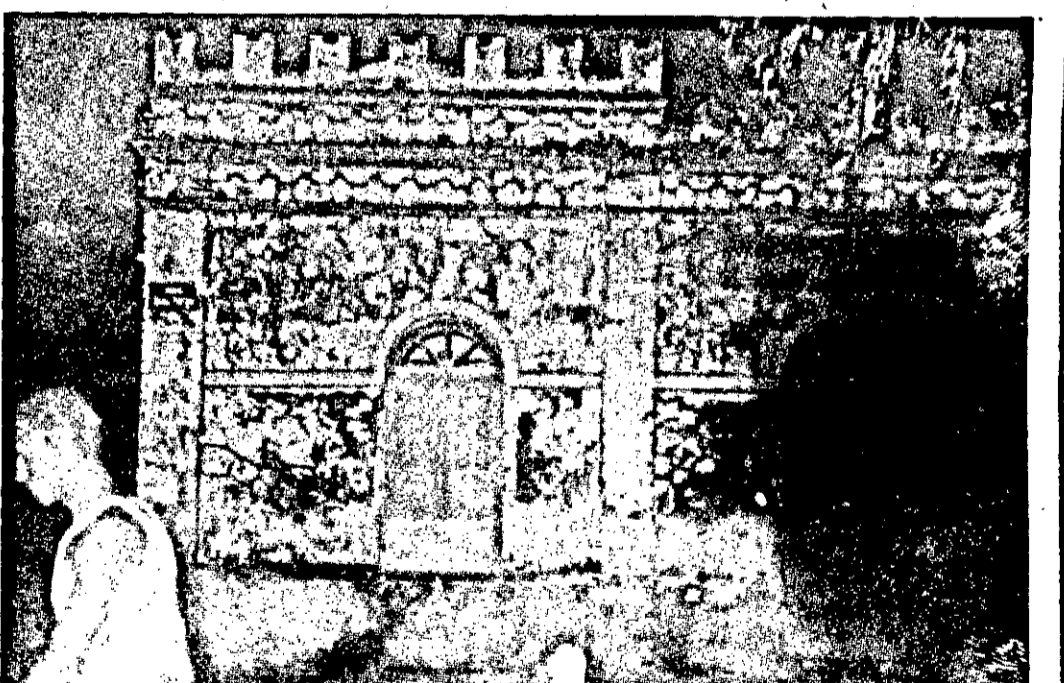
O 4o. Distrito, na rua Divina Pastora, é uma mistura de escombros com matagal.
