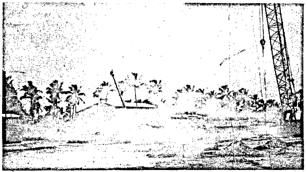
No início, os grandes quindastes impulsionaram o andamento das construções pesadas.
