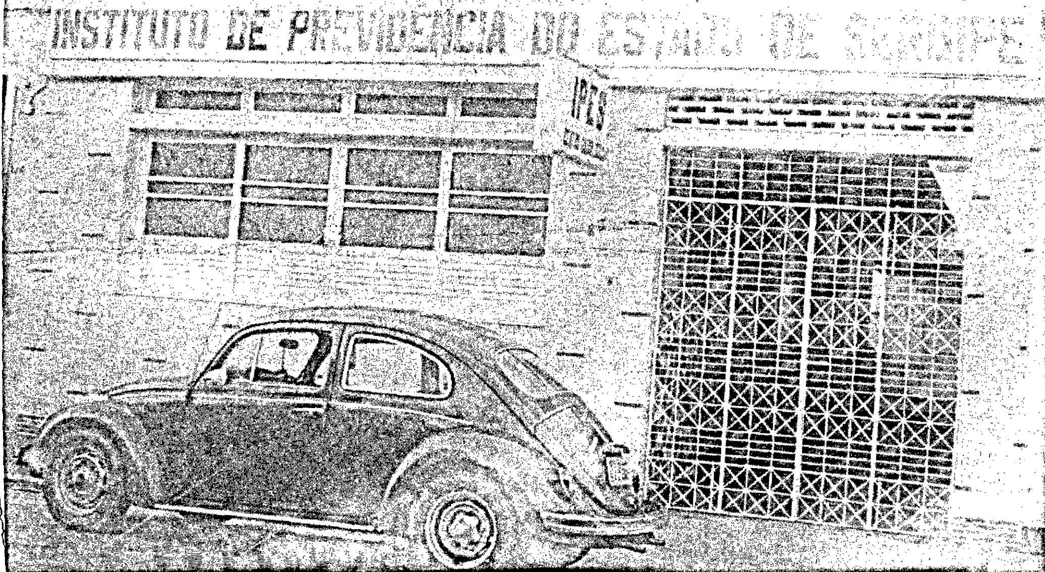
Aspecto da fachada do Centro de Radiológico do IPES.
