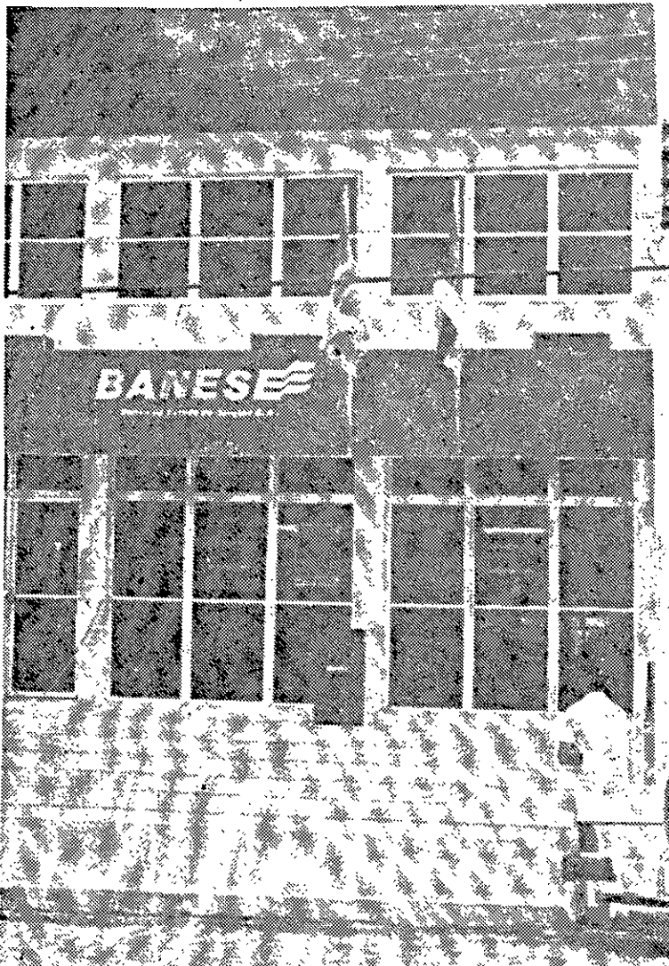
Fachada da agência do BANESE em Nossa Senhora das Dores.
