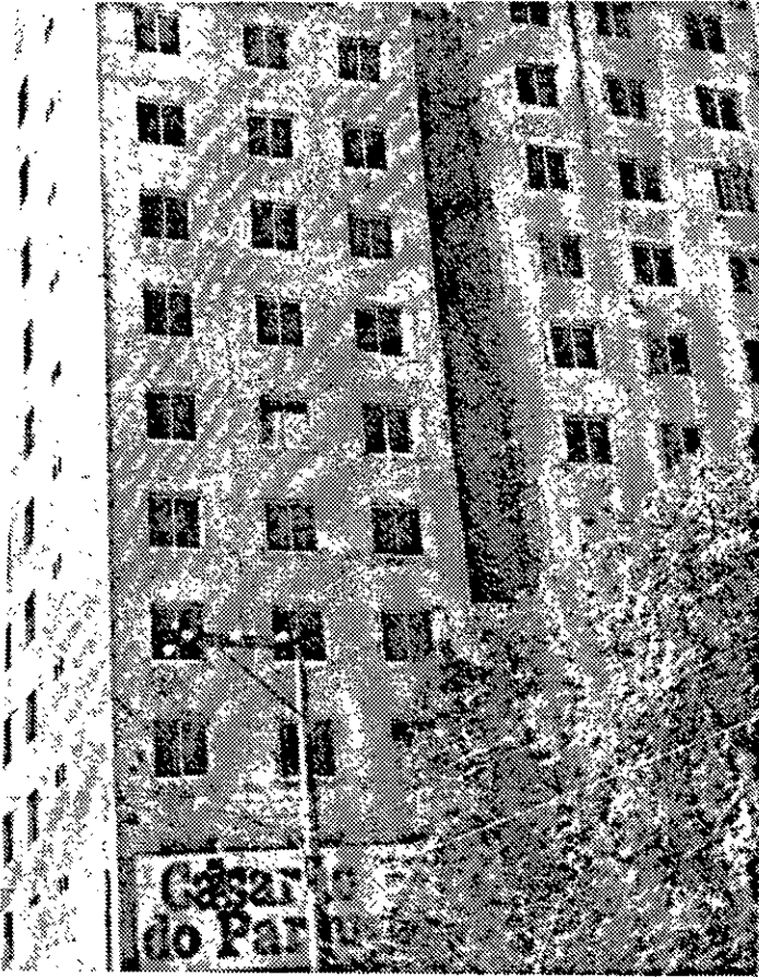
Construções paradas, como esta, são comuns em Aracaju.
