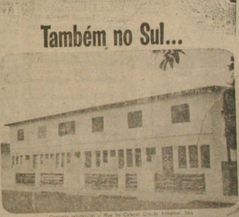
Conjunto residencial - Rua do Calceol, Cidade Anhemar, São Paulo, SP - Tubos e Conexões Tigre nas instalações hidráulicas.
