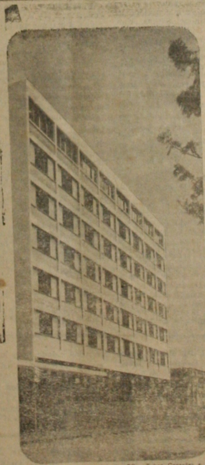
Colón Palace Hotel - Joinville, SC - Tubos Conexões e Eletrodutos Tigre nas instalações hidráulicas e elétricas.
