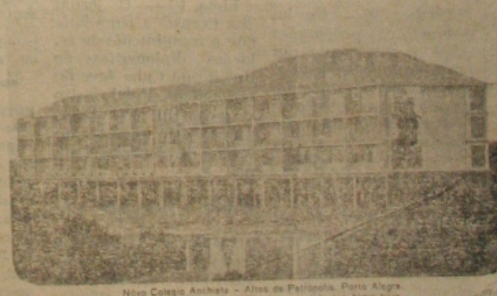
Novo Colégio Anchieta - Alto de Pinópolis, Porto Alegre, RS - Tubos e Conexões Tigre nas instalações hidráulicas.
