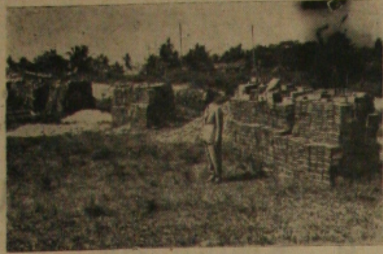
Vista parcial do material adquirido pelo C. S. Sergipe, para as obras já iniciadas do Estádio João Hora de Oliveira. O presidente do Acs, vereador Narcizo Machado, quando visitava o local.
