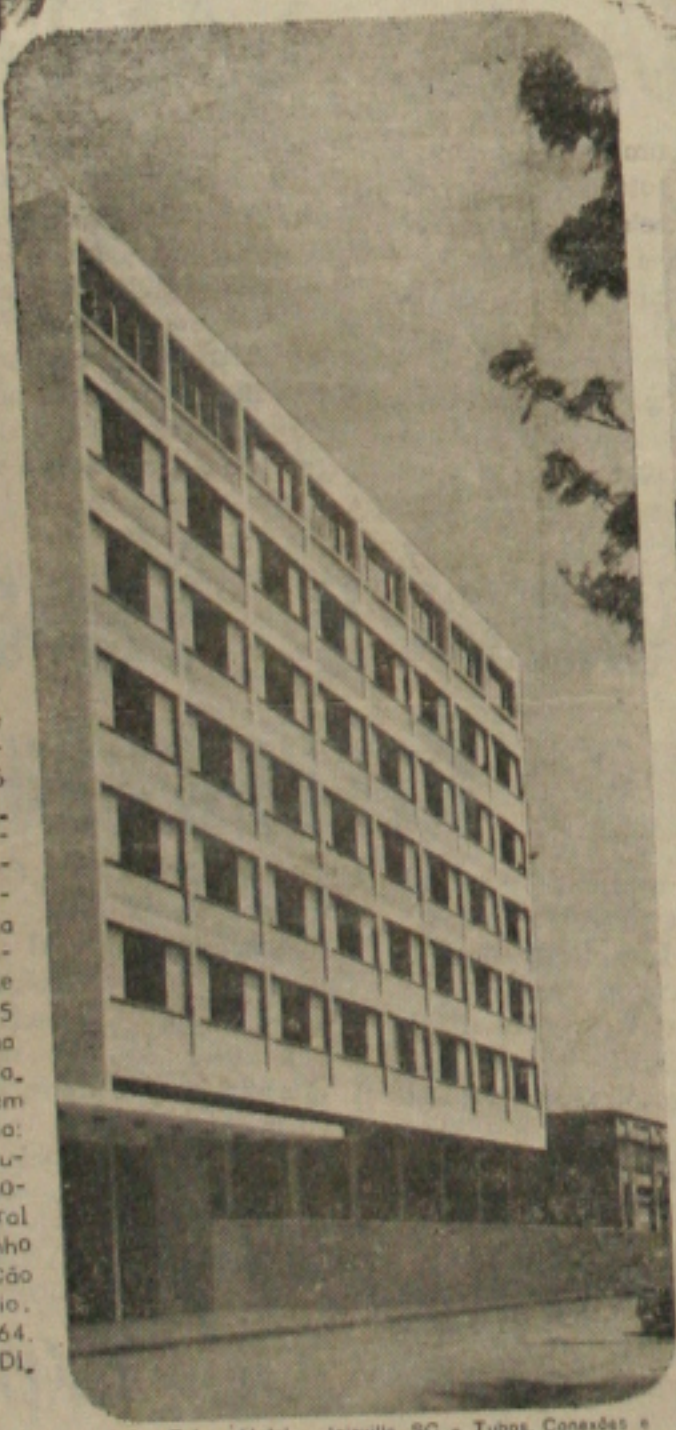
Colón Palace Hotel - Joinville SC - Tubos, Conexões e Eletrodutos Tigre nas instalações hidráulicas e elétricas.
