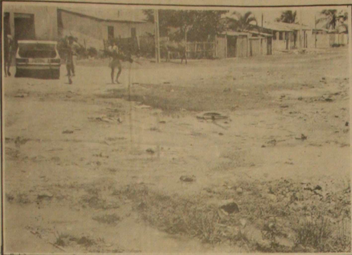
Na Atalaia Velha, as ruas estão sendo invadidas pelas águas dos esgotos diante da ineficiência da administração municipal.
