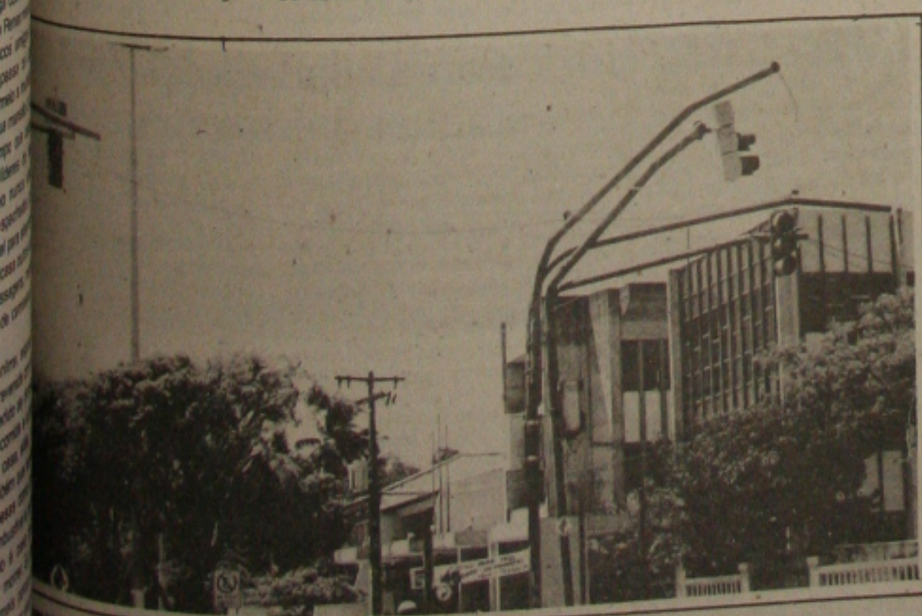
Detran inicia instalação de novos semáforos em Aracaju
