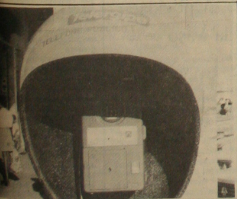
Os aparelhos danificados com os orelhões em Aracaju.
