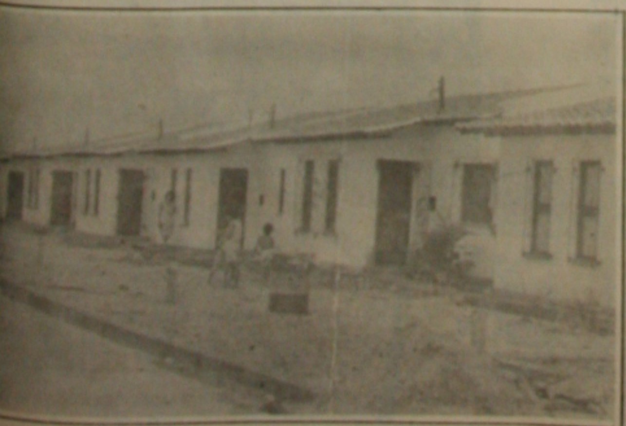
Um dos prédios do Conjunto Marcos Freire, a Prefeitura de Socorro não realizou nenhuma obra de infraestrutura (Foto: Fernando Silva).
