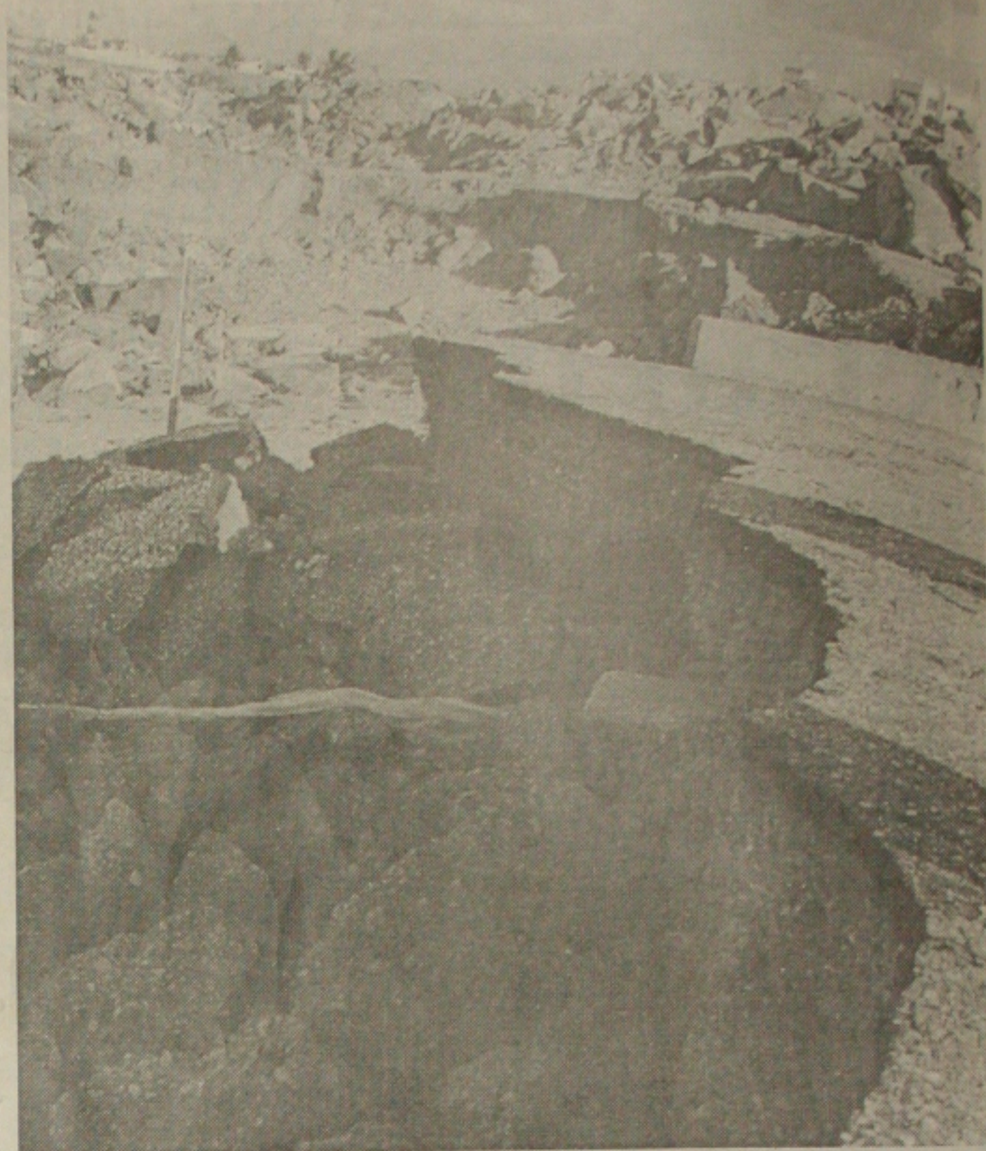
Pista de uma das ruas da Coroa do Meio cedeu com o avanço da maré
