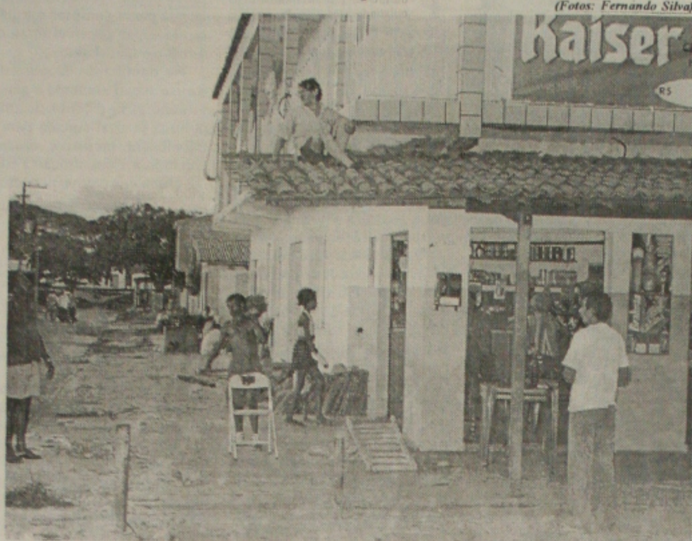
Comerciante subiu na cobertura para não perder as telhas
