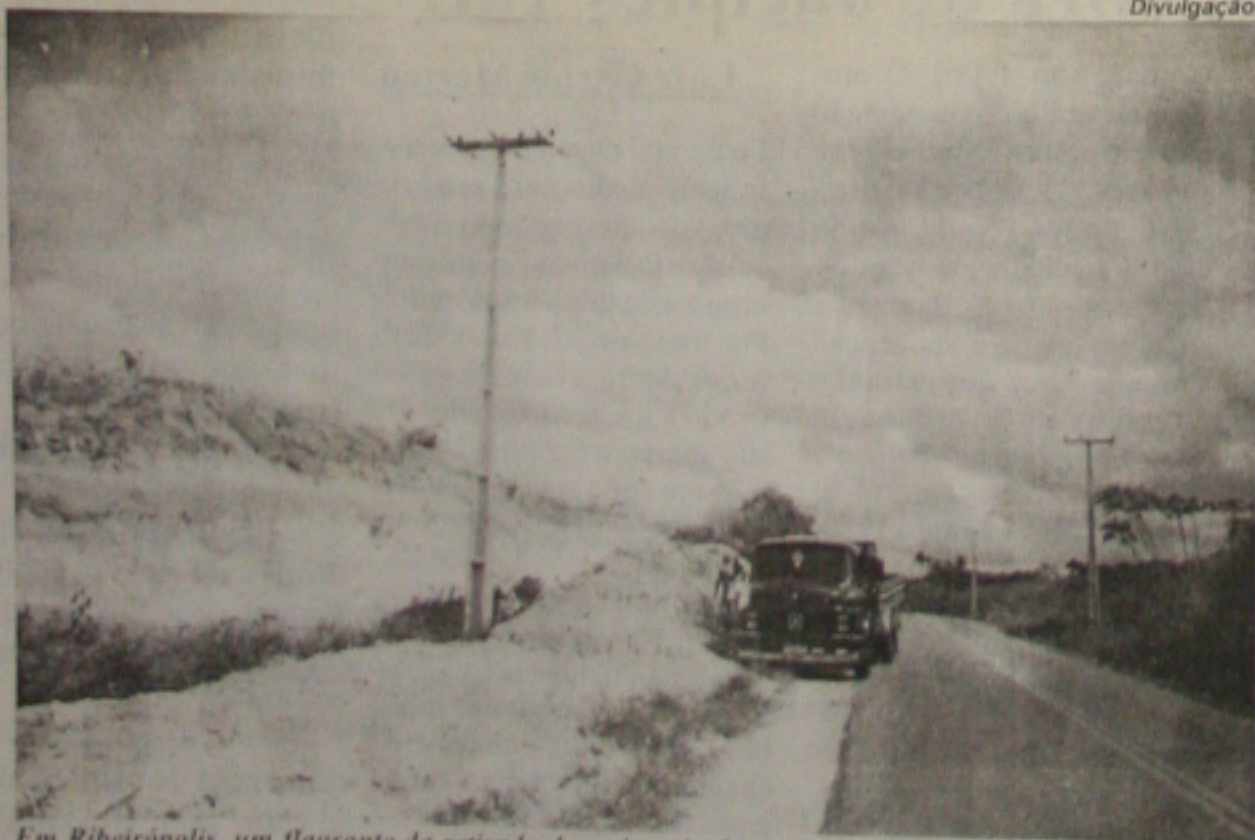
Em Ribeirópolis, um flagrante da retirada desordenada de areia, às margens da rodovia
