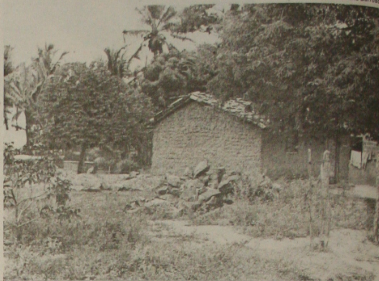
A construção de casas de alvenaria ficou apenas em mais uma promessa na cidade de Itaporanga
